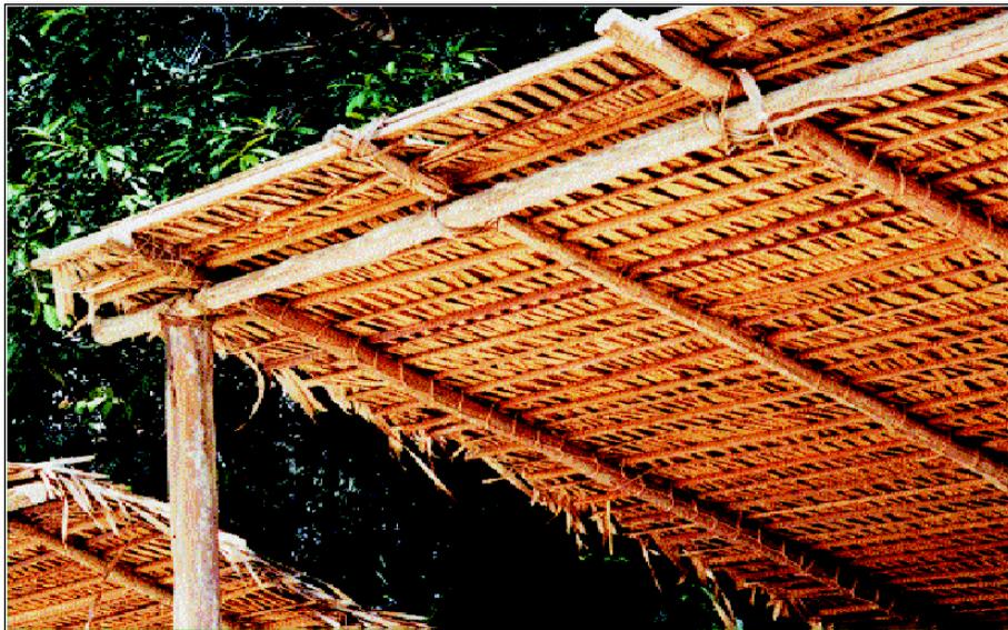
Fig 5-23. Tapiri simples de moradia: detalhe da cobertura
